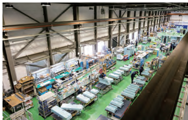
上:船舶用分電盤 下:工場内の様子
